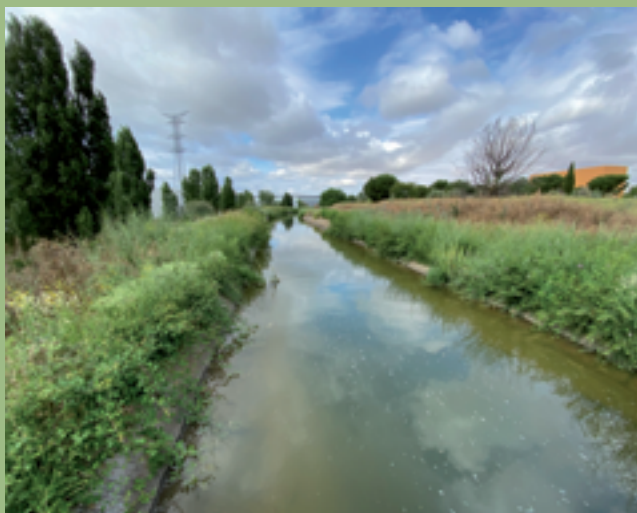
Canal de Henares
