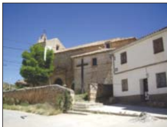
Iglesia de Piqueras
